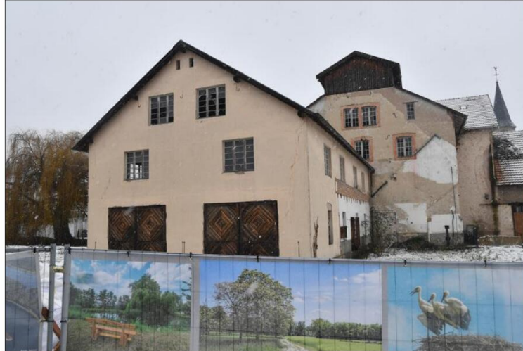
La réhabilitation du moulin de Gerstheim fait partie des cinq projets du canton d'Erstein à bénéficier d'une subvention allouée par l'ancien CD67. Photo DNA/Michel FRISON
